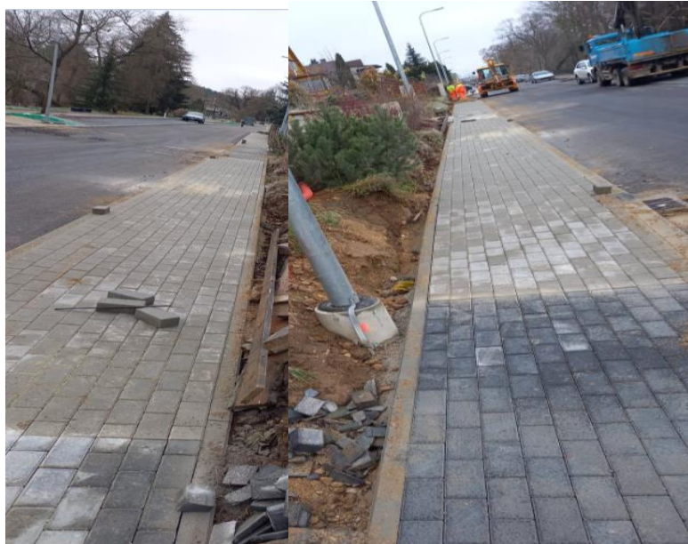
13 paveikslas. Anykščių miesto Žvejų gatvės rekonstravimo darbai
