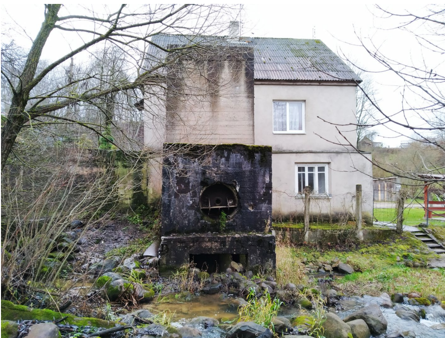
5 pav. Buv. malūno pastatas, vandens įleidimo bei darbo rato kamera.
