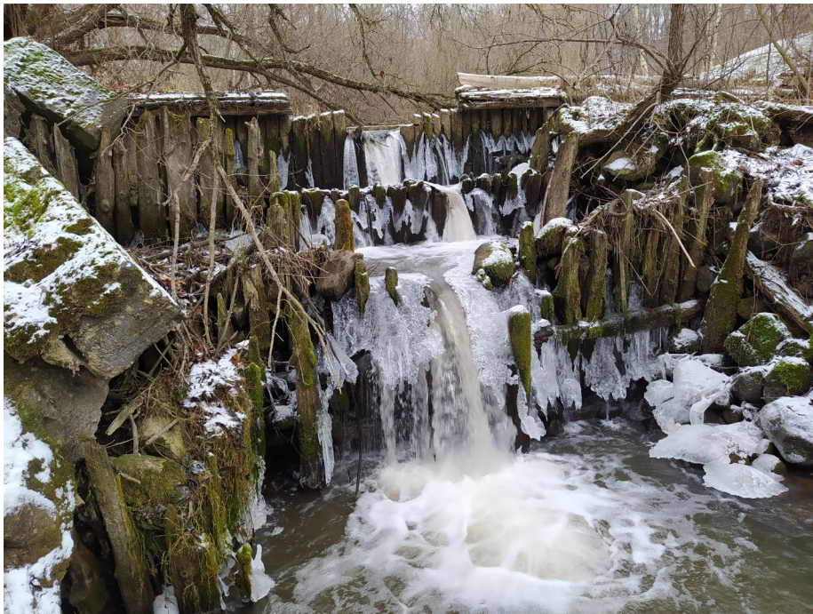
2 pav. Medžio - akmenų - akmenbetonio užtvanka - slenkstis. Vaizdas nuo žemutinio bjefo.
