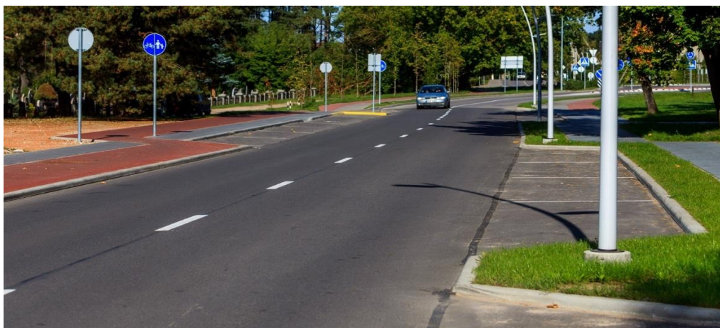
54 paveikslas. Vilniaus gatvės rekonstrukcija 20
