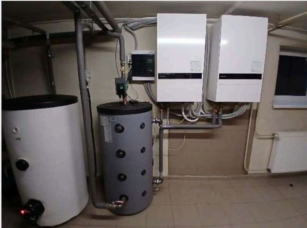
Burbiškio padalinyje įsigyta nutolusi saulės elektrinė ir įrengta šildymo sistema oras – vanduo.
