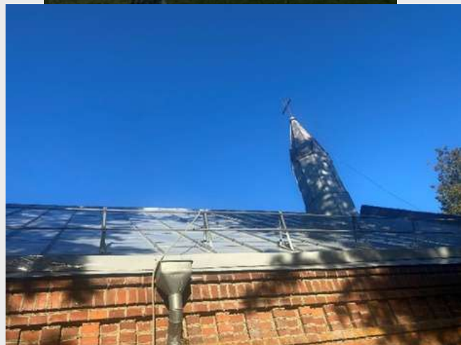
Atlikti Dabužių Kristaus Žengimo į dangų bažnyčios stogo remonto darbai 21
