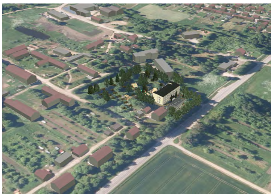
Kapitaliai remontuojamas pastatas urbanistinėje aplinkoje
